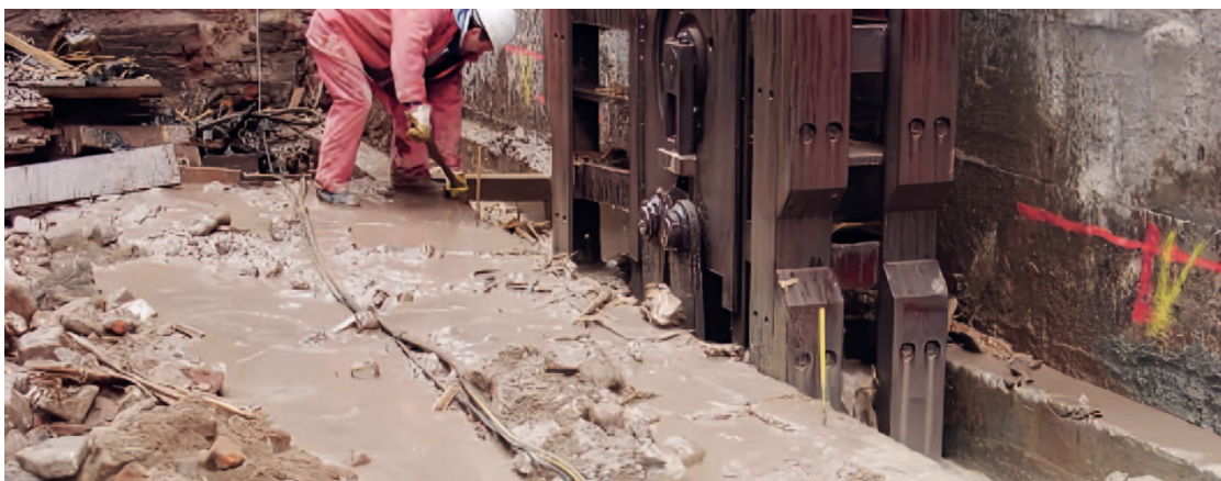
Abbildung 9: Leitwandkonstruktion für Schlitzwandgreifer vor aufgehendem Gebäude
