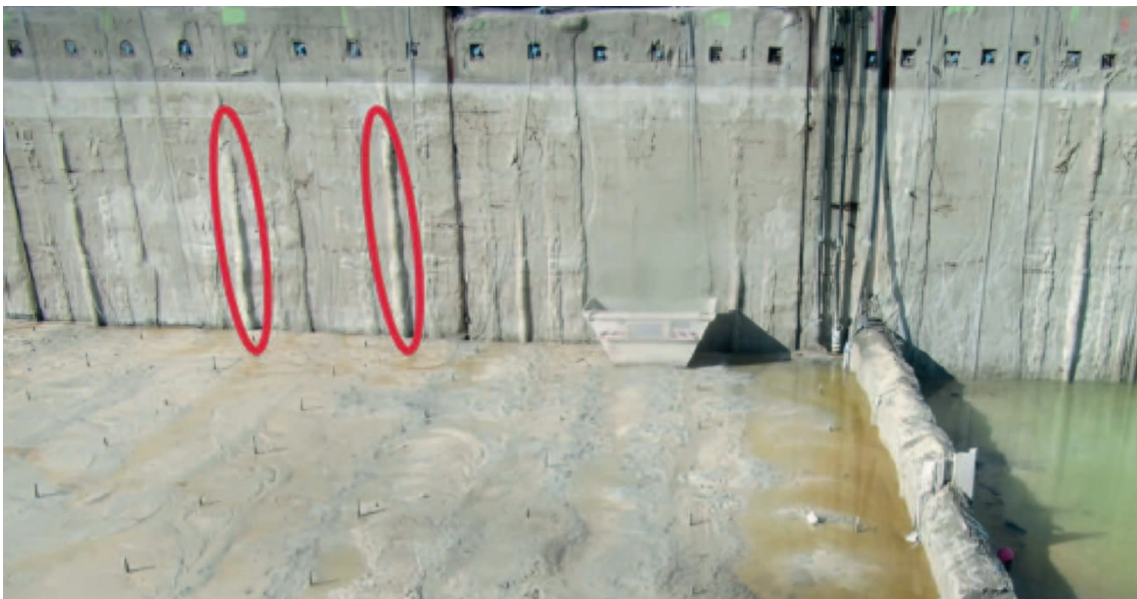
Abbildung 13: Vorwüchse Schlitzwand
