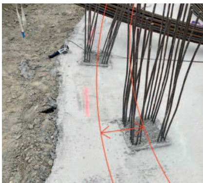
Abbildung 14: Versetzter Pfahl bzw. Zusatzbewehrung für Fundamenteinbindung
