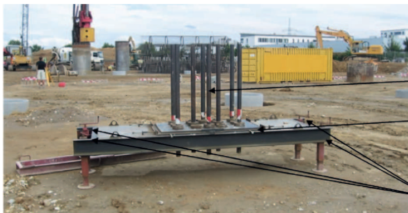
Abbildung 15: Einbauvorrichtung für Fertigteilstützen
