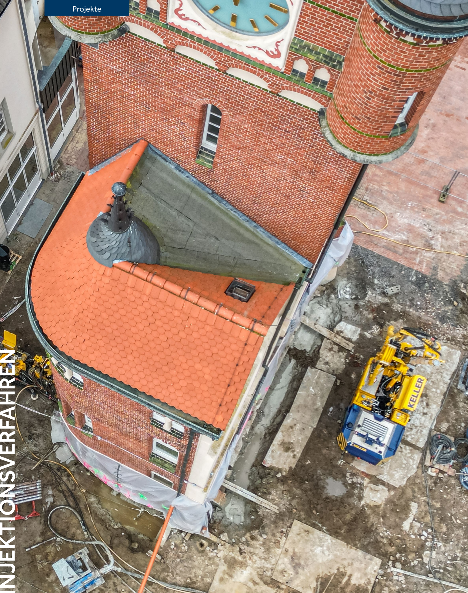
Unterfangungsarbeiten am ehemaligen Rathaus in Gronau
