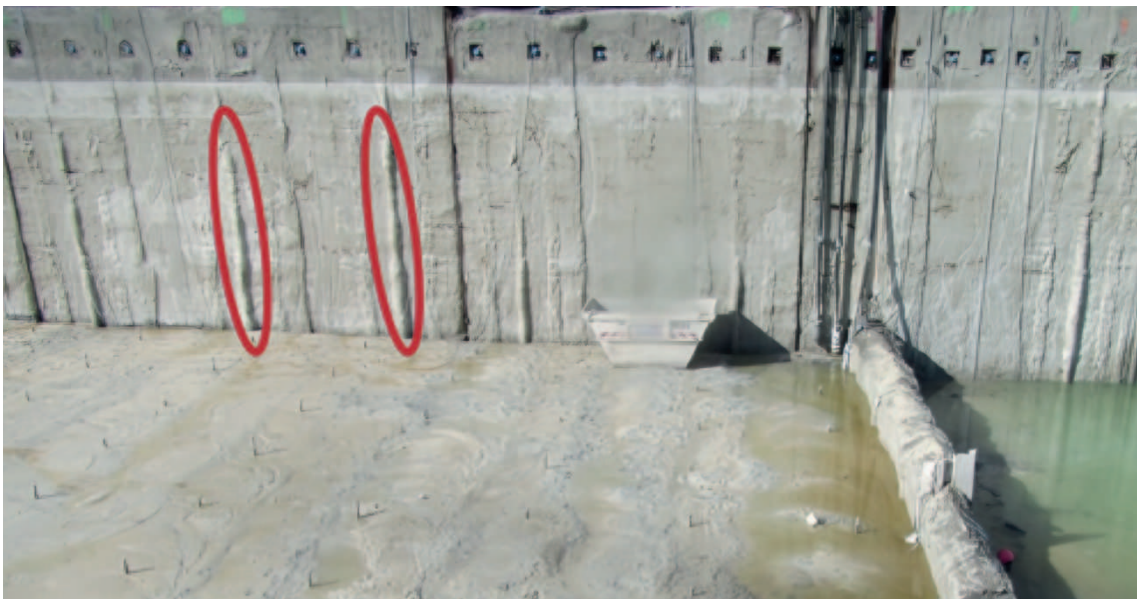
Abbildung 13: Vorwüchse Schlitzwand
