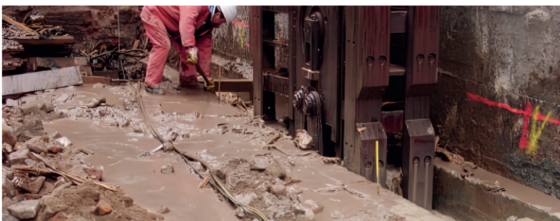
Abbildung 9: Leitwandkonstruktion für Schlitzwandgreifer vor aufgehendem Gebäude
