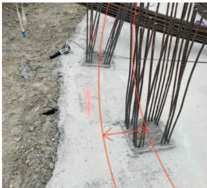
Abbildung 14: Versetzter Pfahl bzw. Zusatzbewehrung für Fundamenteinbindung
