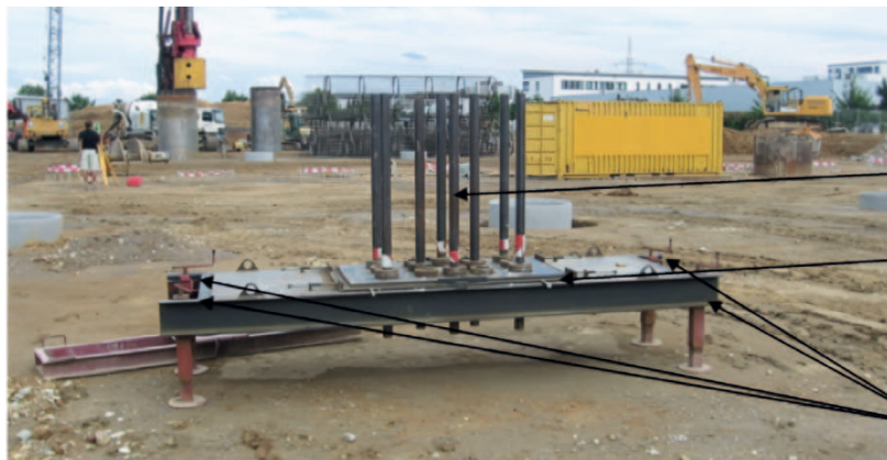
Abbildung 15: Einbauvorrichtung für Fertigteilstützen
