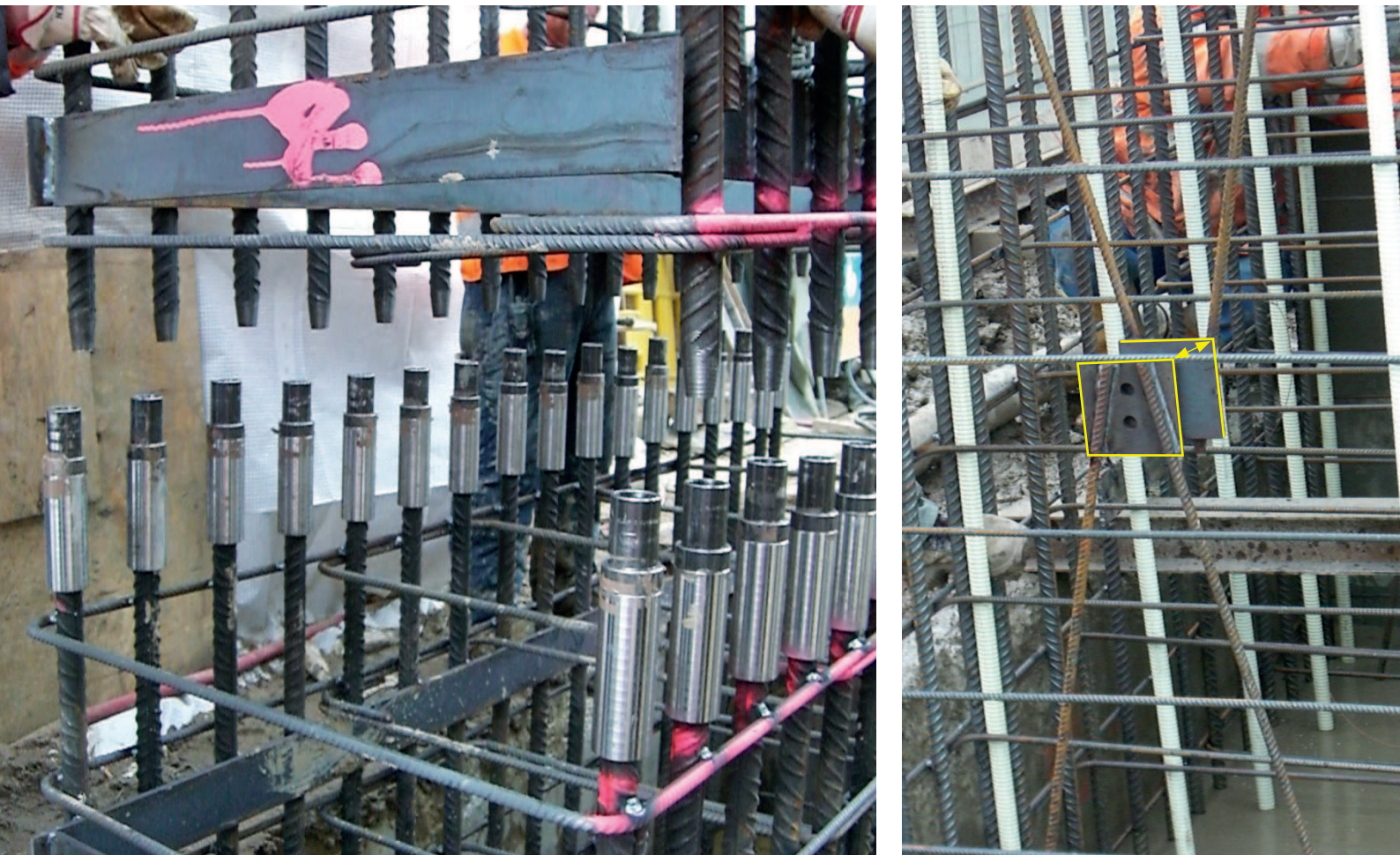
Abbildung 10: Varianten für den Zusammenbau von Bewehrungskörben (hohe Genauigkeitsanforderungen)
