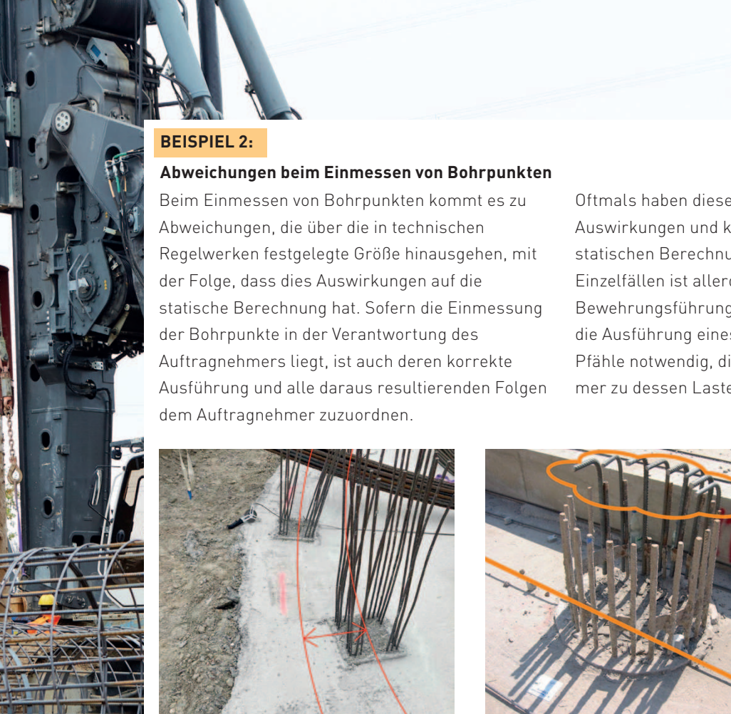
Abbildung 14: Versetzter Pfahl bzw. Zusatzbewehrung für Fundamenteinbindung
